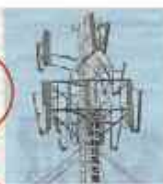
Una antena repetidora
